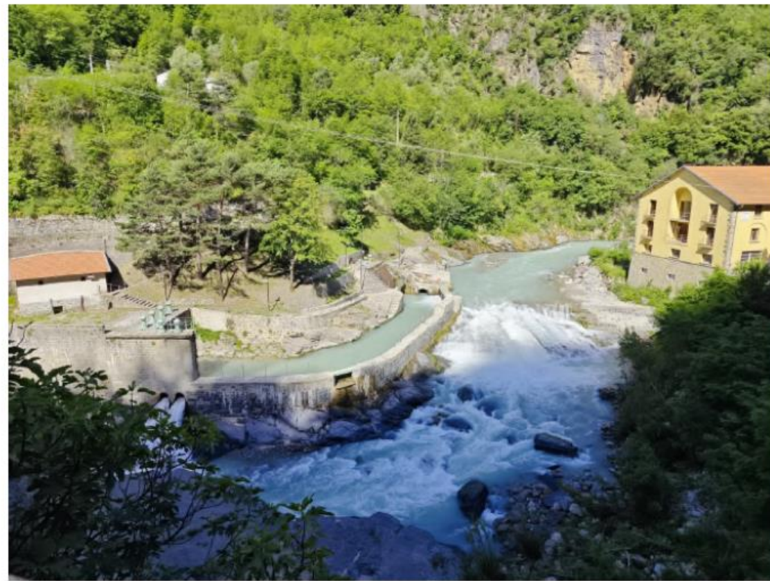
Vésubie et station électrique EDF
